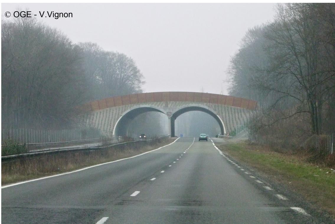
**Photo 2** : Large ouverture du passage de la RN2 de 35 m de large. Une bande de sable disposée au centre permet de lire les traces des animaux. L'ouvrage juste fini n'est pas encore couvert de végétation, mars 2010.
